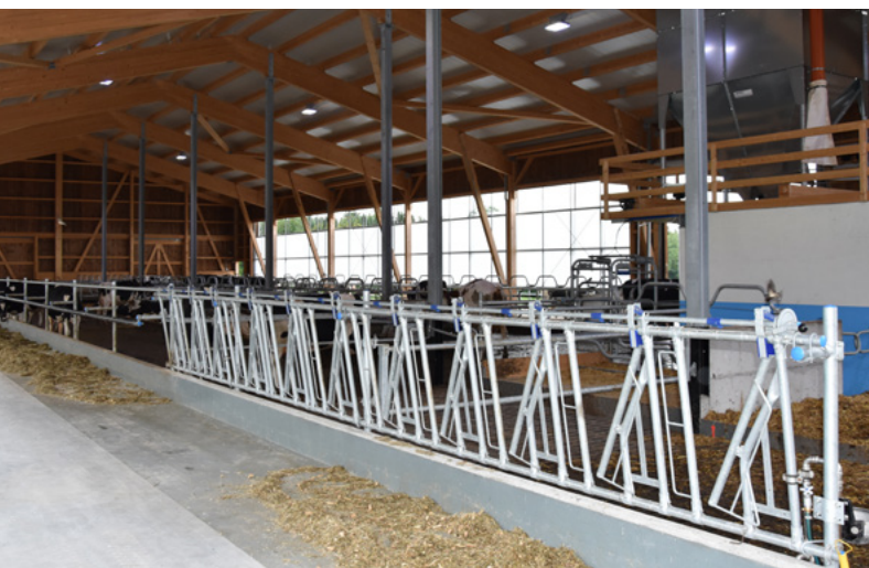
Das LED Licht soll den Stall gleichmässig ausleuchten.
